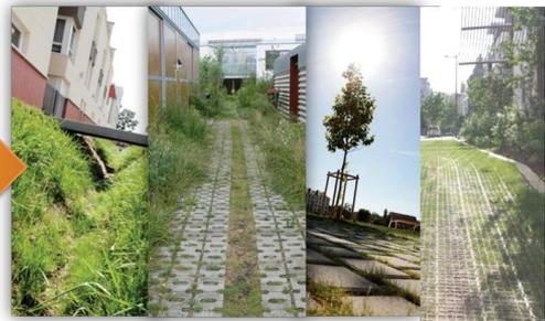
Les noues ou les pavages permettent à l'eau de s'infiltrer dans le sol
