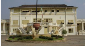
Privilégier la relocalisation de la mairie dans le bâtiment de l'actuelle Assemblée Nationale
