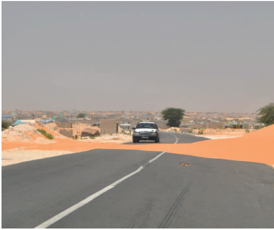
Ensablement de la route Photo : Giulia Carlone
