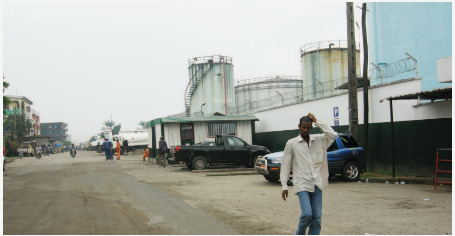
30 Réservoirs d'hydrocarbure dans le quartier de Bessengue
