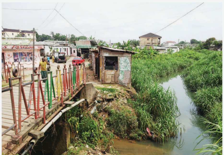
33 Drain dans le quartier de Bonantone
