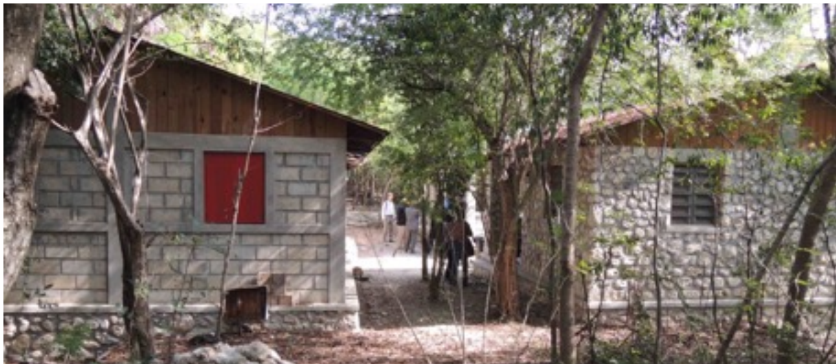
Maisons de la reconstruction post-séisme réalisées sous la conduite d'ITECA (Institut de Technologie et d'Animation) présent depuis plus de 30 ans à Léogâne.
