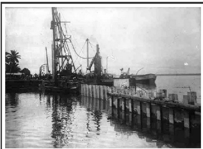
Travaux sur le port de Douala
