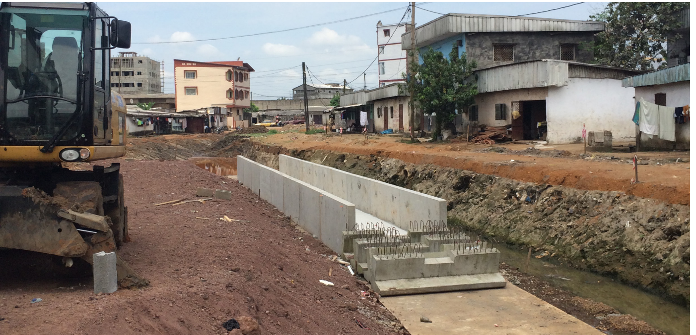
Phase 2: Installation des drains à Nkoulouloum
