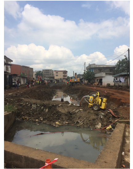
Phase 1: Curage des Drains à Nkoulouloum
