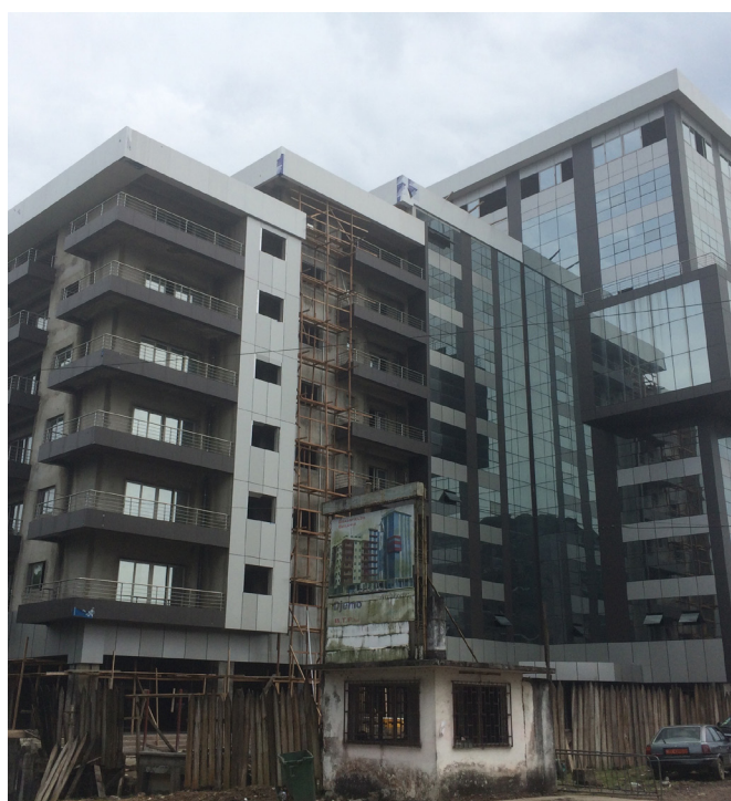
Immeuble de bureaux et logements en construction à Bonanjo
