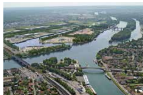
Vue aérienne de la Confluence Seine-Oise aujourd'hui - CCI Ile-de-France
