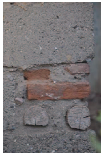
Utilisation du bois, de briques et de béton combinés
