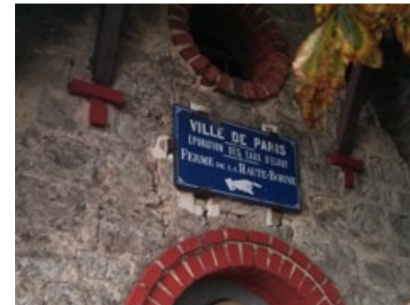
Epuraton des eaux de la ville de Paris
