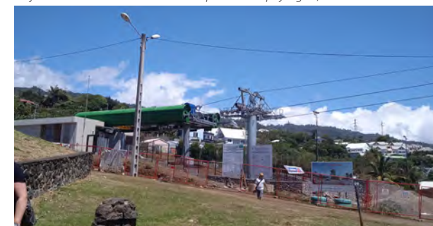
Téléphérique en préparation, Les Ateliers ©
