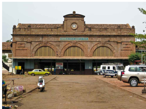
Photo des rails et des entrepôts de Transrail et photo de la gare de Bamako.
