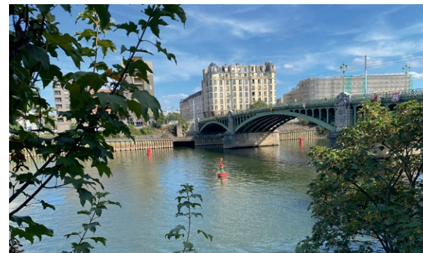
Le pont entre Saint-Denis et l'Île-Saint-Denis
