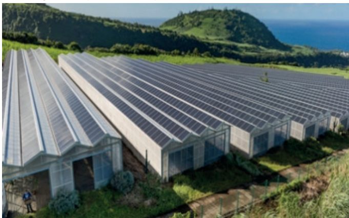
Ferme agri-voltaïque Saint-Joseph (Akvo)
