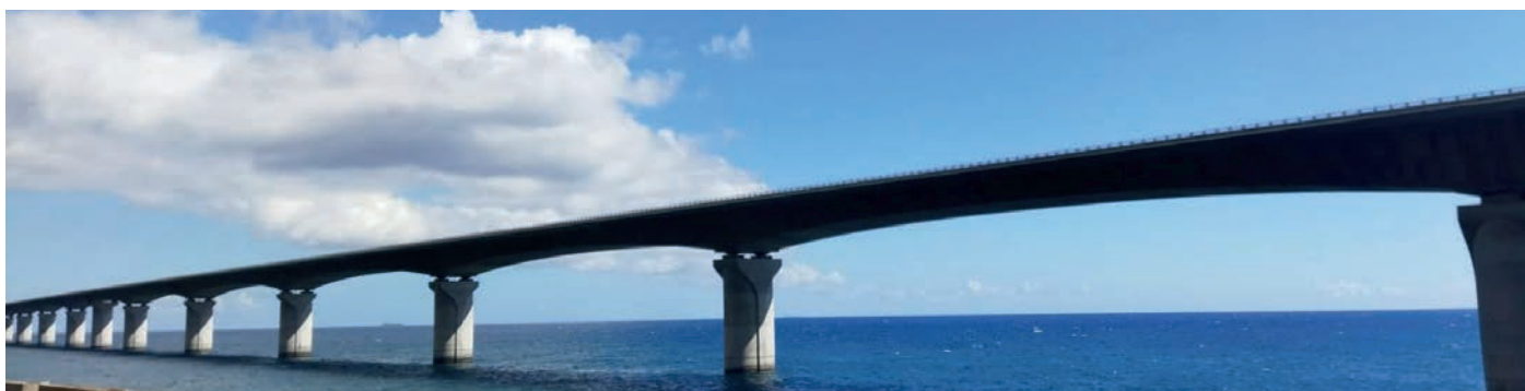
La Nouvelle Route de Littoral en cours de construction, Mai 2021
