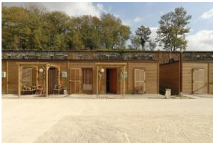
Opération ADOMA, hébergement d'urgence à Saint-Denis Fort de l'est.
