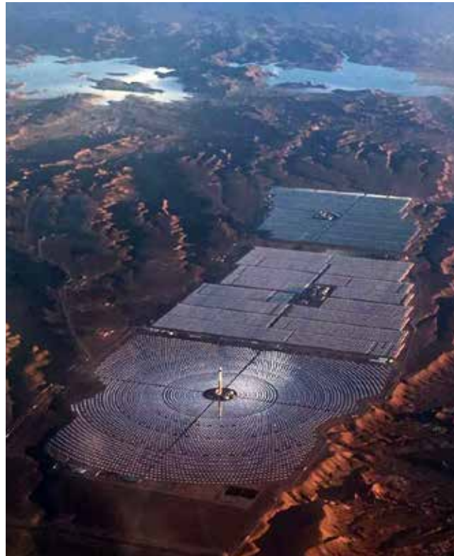
Le complexe thermo-solaire Noor- vue depuis l'avion
