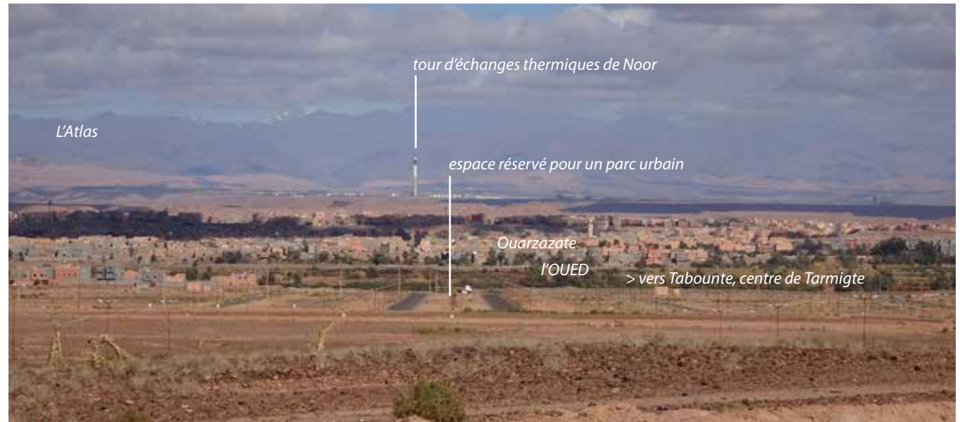
Le site du futur pôle urbain, côté Tarmigte: 350 ha, 7756 lots, environ 80 000 habitants à terme
