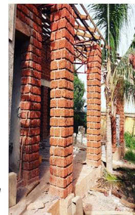
Type de construction en brique de terre cuite BTC.
