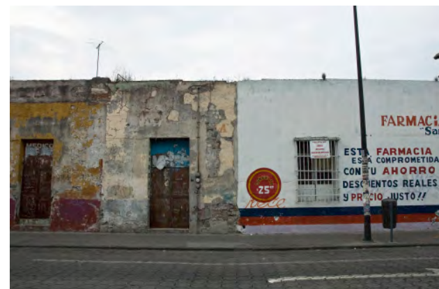
Imagen 2 Rehabilitación parcial de vivienda
