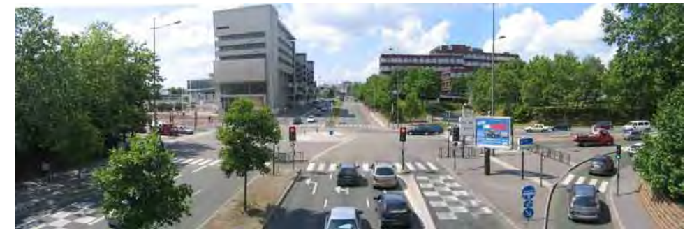
Vue panoramique du boulevard de l'Oise: à la sortie de la dalle sous Cergy-Préfecture
