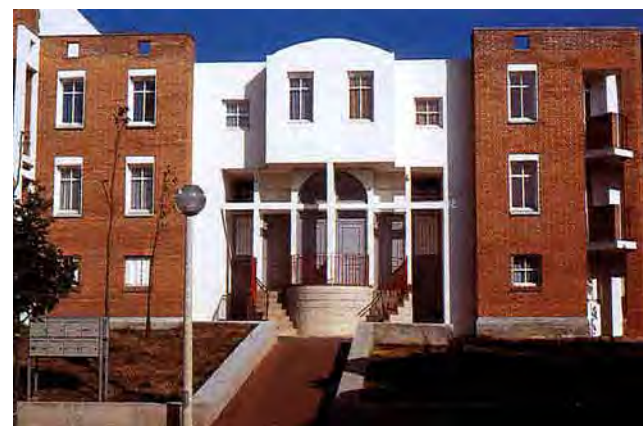
Années 80-90: Cergy St Christophe, immeubles de ville Source: Vincent Girard, «C'était la Ville Nouvelle», SOMOGY 2002
