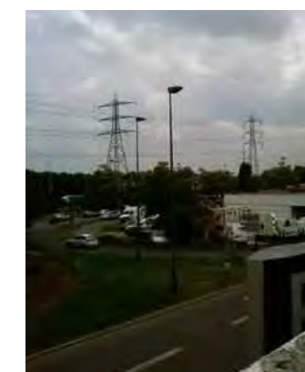
En centre ville, les lignes électriques longent l'A15 et sont un élément structurant du paysage
