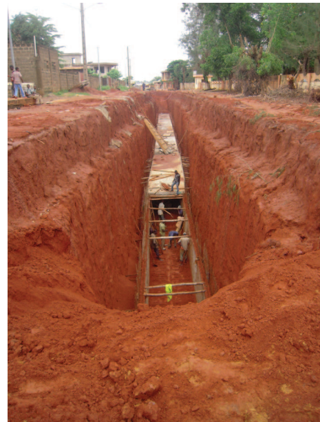
La construction d'un Réseau d'évacuation des eaux à Anavié : collecteur G - The construction of a drainage network to Anavié: manifold G
