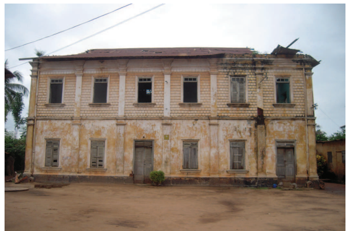
Une Maison de caractère dans le centre, dégradée par le temps A house with character in the center, damaged by the time
