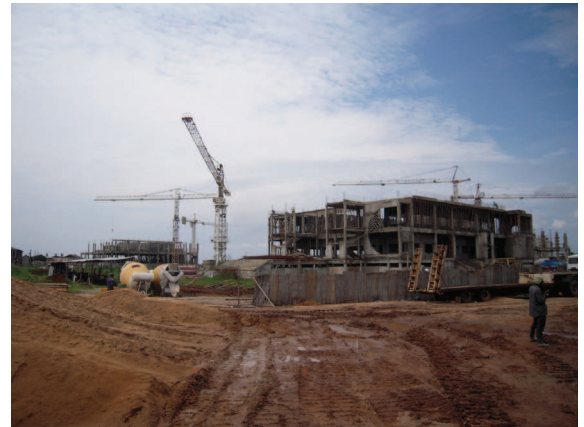
Le chantier de la nouvelle assemblée nationale à Porto-Novo
