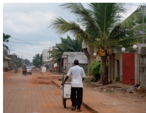
Voie pénétrante en direction de Lokpodji (route n°336) Penetrating way towards Lokpodji (road 336)
