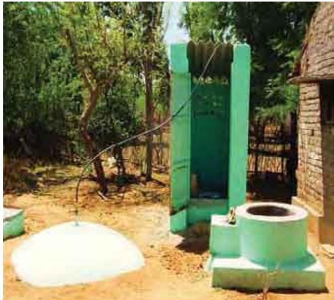
Figure 3 : Toilettes connectées à un digesteur de biogaz
