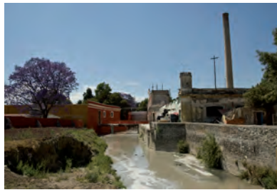
17 Etat actuel de de l'usine La Constancia, en cours de rehabilitation
