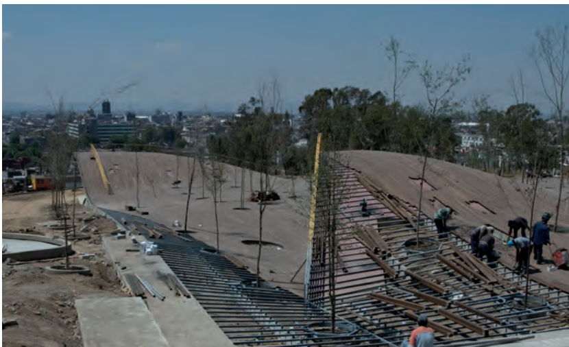
Figure 7 L'un des miradours de Los Fuertes en cours de construction (avril 2012)
