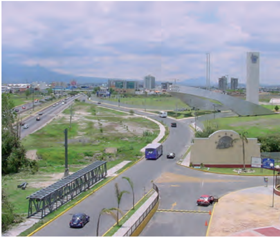
Figure 1 Campus du Tec de Monterrey, à Angelópolis Source: http://www.cholulacity.info/2011_05_01_archive.html
