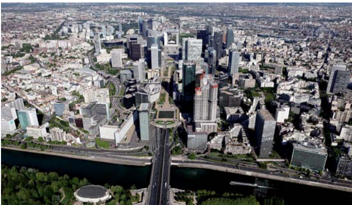
Vue sur le site de La Défense vers l'ouest (EPADESA)
