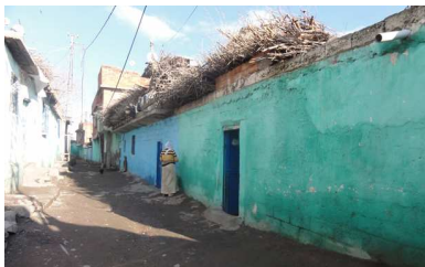
Fagots pour le chauffage stockés sur les toits.
