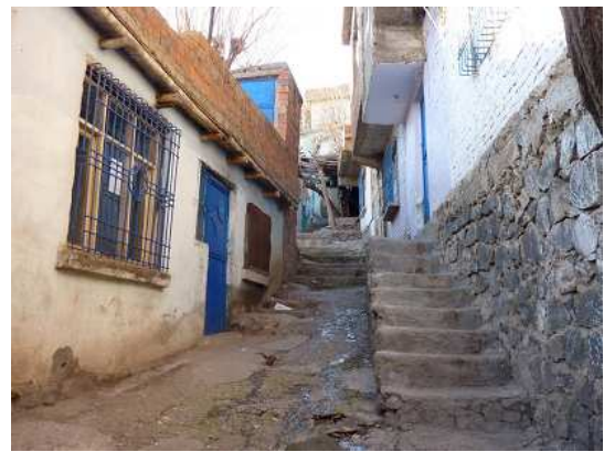
Accès par des escaliers aux logements sur les pentes.
