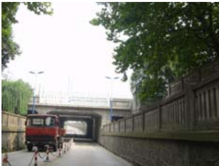
Rue Changqin et le tunnel qui passe sous les voies ferrées.
