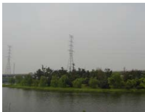
L'autoroute Yanjiang (le long du fleuve Yangtze)
