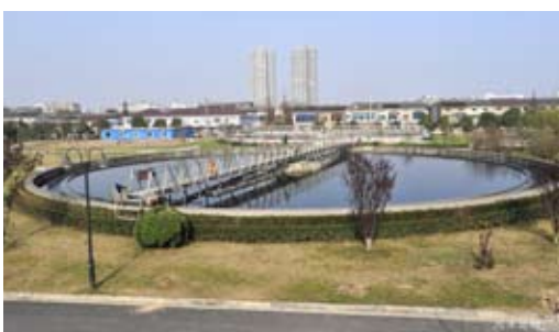
Une usine de traitement de l'eau
