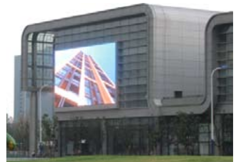
La nouvelle façade nord de la gare centrale
