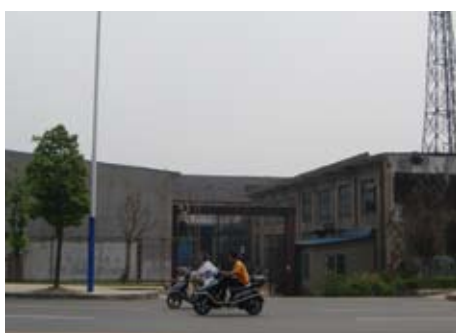
Les industries sont très présentes dans le secteur mais avec les styles architecturaux peu qualifiés. Les locaux de CSR sont par contre très modernes.
