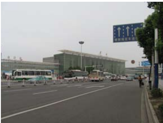
Vue sur l'entrée sud de la gare centrale
