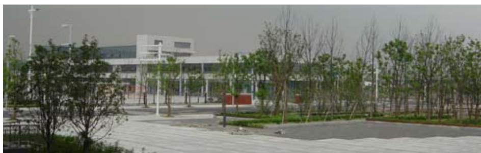
Zones A et B Place Nord et bureaux Partie du projet déjà achevé devant la gare
