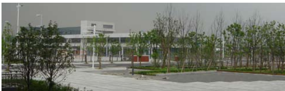
A地块和B地块站前的北广场和办公区域项目已经竣工。
