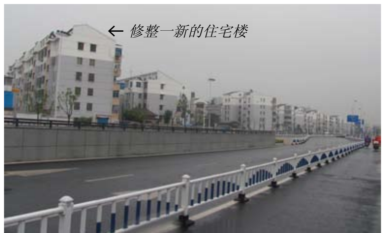
火车站前近期整修的道路
