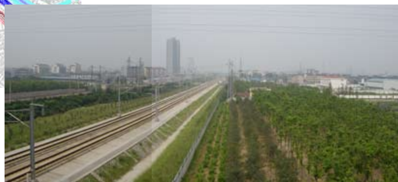
从沿江高速公路看威墅堰火车站地区
