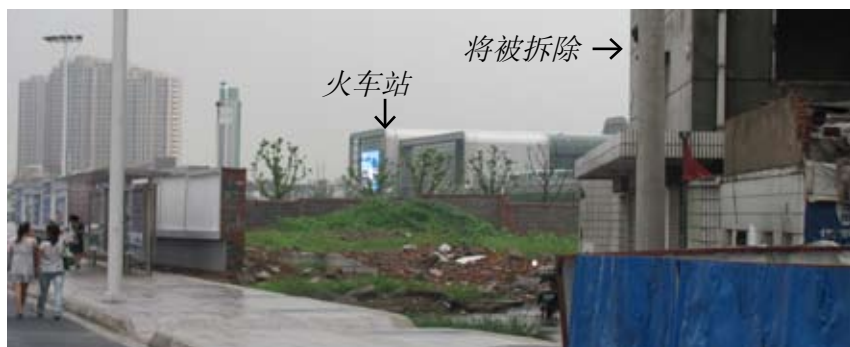
火车站周围许多建筑已被拆除以作为规划预留地
