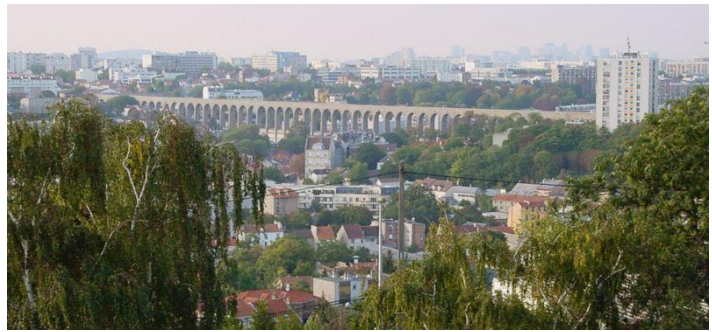
photo du viaduc d'Arcueil
