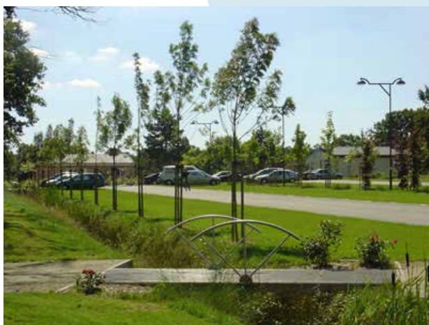
Stationnements végétalisés et perméables qui évitent le ruissellement des eaux et améliorent la qualité du paysage.
