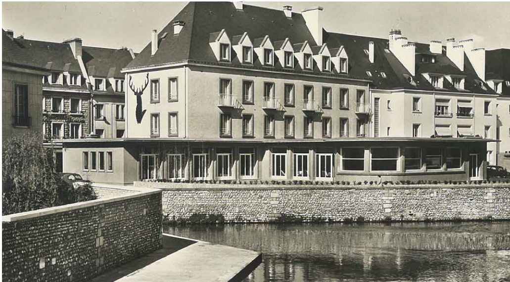
Evreux la reconstruction : le miroir d'eau et la promenade de l'Iton (A de Brettes architecte), l'hôtel du Grand Cerf (P. Dupont architecte) et maisons de ville en alignement le long de la rue de la Harpe élargie en conservant son tracé initial.
