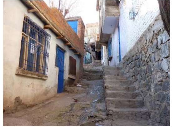
Eğimli arazi üstündeki konutlara erişimi sağlayan merdivenler
