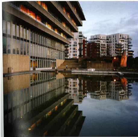
La tour Cergy préfecture
