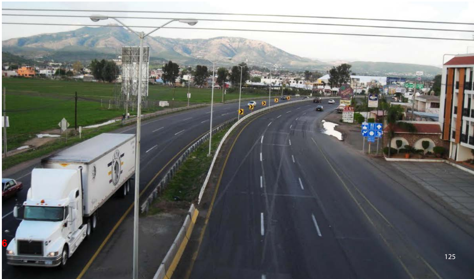
L'autoroute fédérale 45 au coeur de la zone urbaine de Silao.
