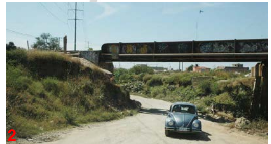
Passage sous la voie ferrée pour rejoindre le bord de la rivière Silao.
