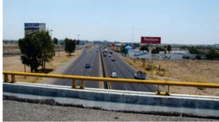
L'autoroute 45 est très difficilement franchissable et constitue une limite forte dans le territoire métropolitain.
