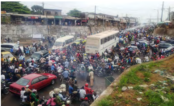
A la sortie du «Tunnel Ndokoti» en allant vers le carrefour Ndokoti - Lundi 07h30 : Absence de signalisation (quelques policiers essaient d'organiser le trafic) et très mauvais état des routes (nids de poules)
