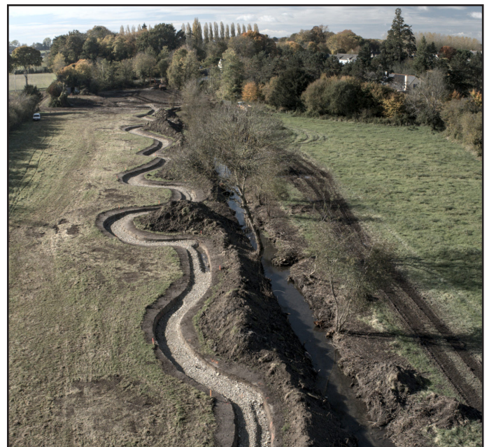
Avancement des travaux de renaturation du ruisseau de Marcé ©SMBVAR
