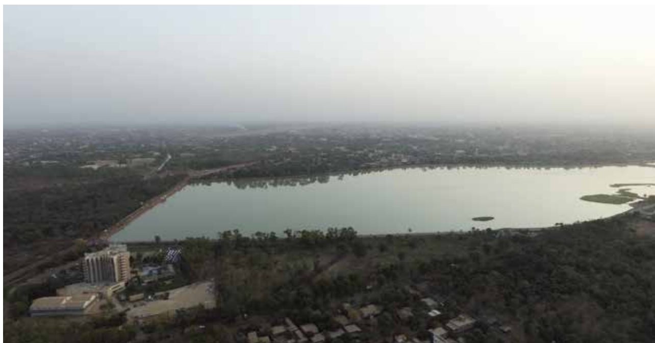
Fig 2 : Vue aérienne du barrage 3 de Ouagadougou
