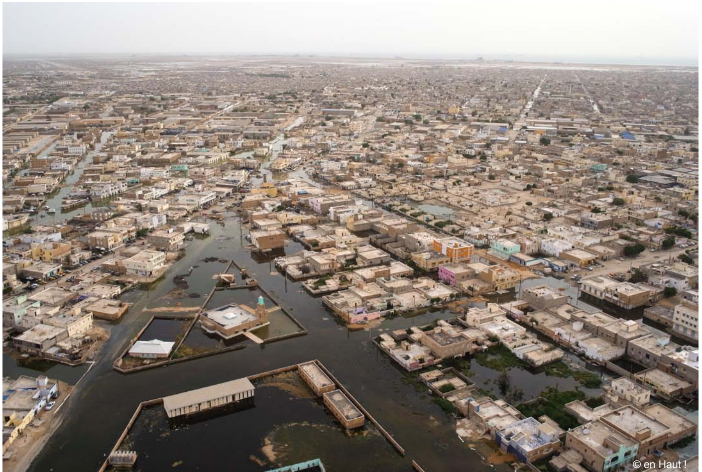
Inondations au Ksar, septembre 2013
