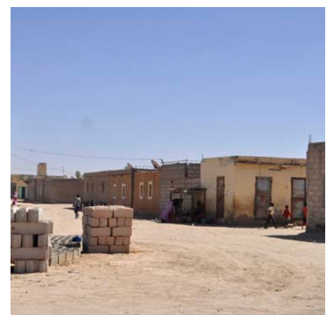
Restructuration de El Mina, 2014
