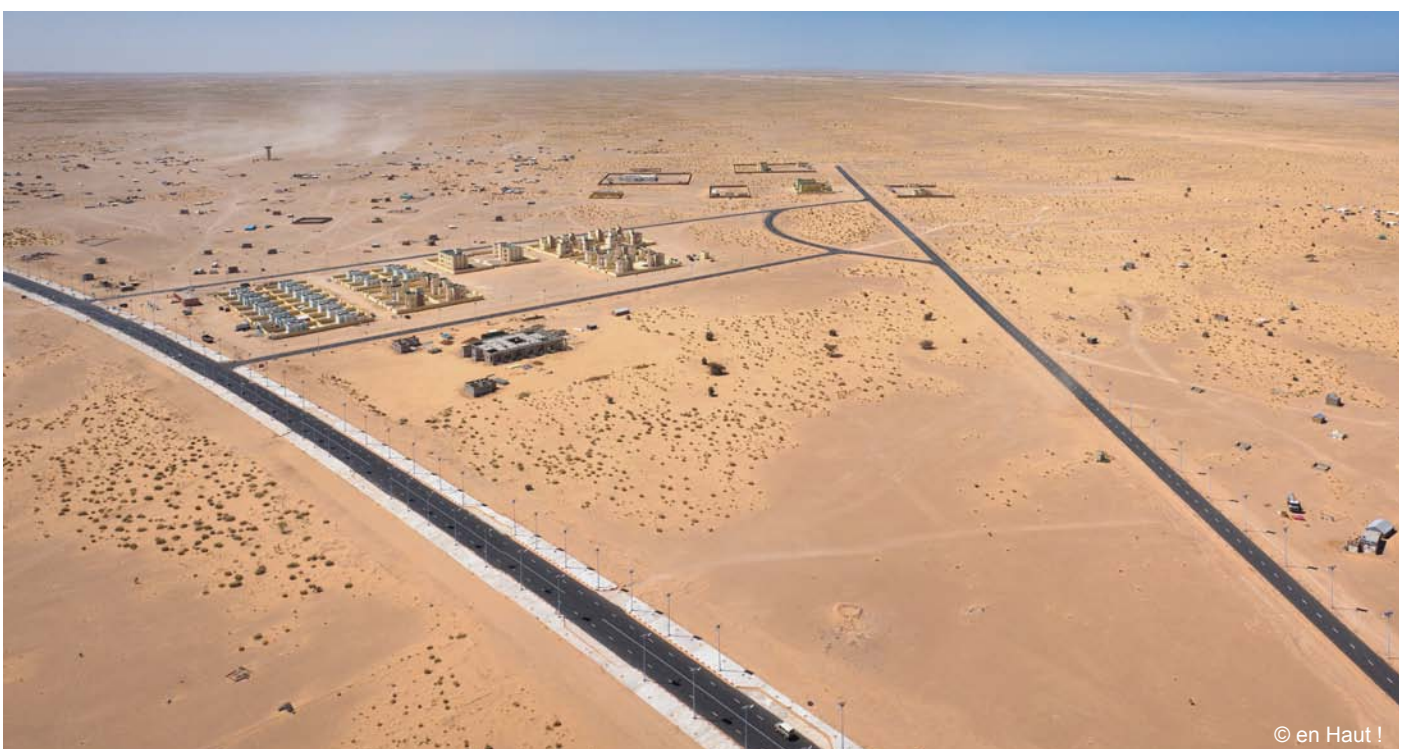
Vue aérienne de Chami
