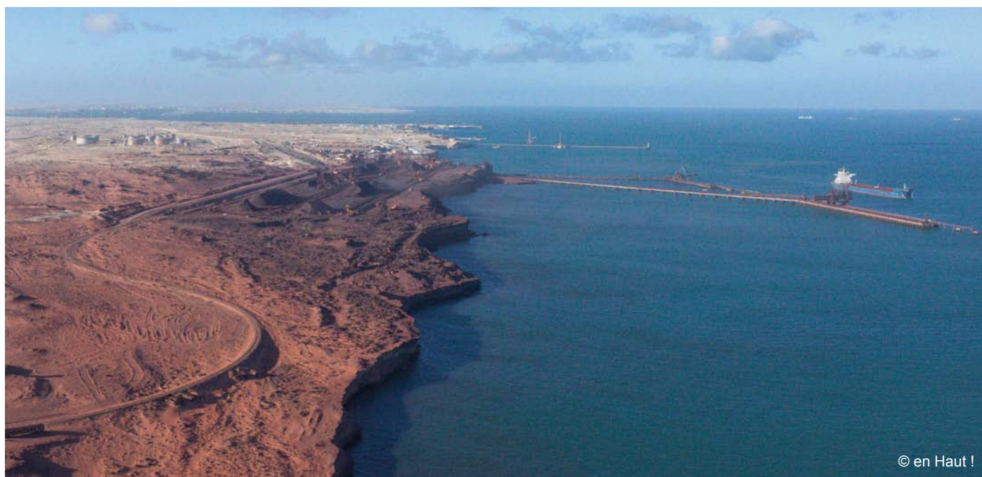
Port minéralier de la SNIM à Nouadhibou
