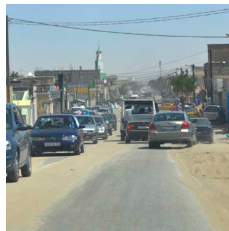
Voirie goudronnée secondaire
