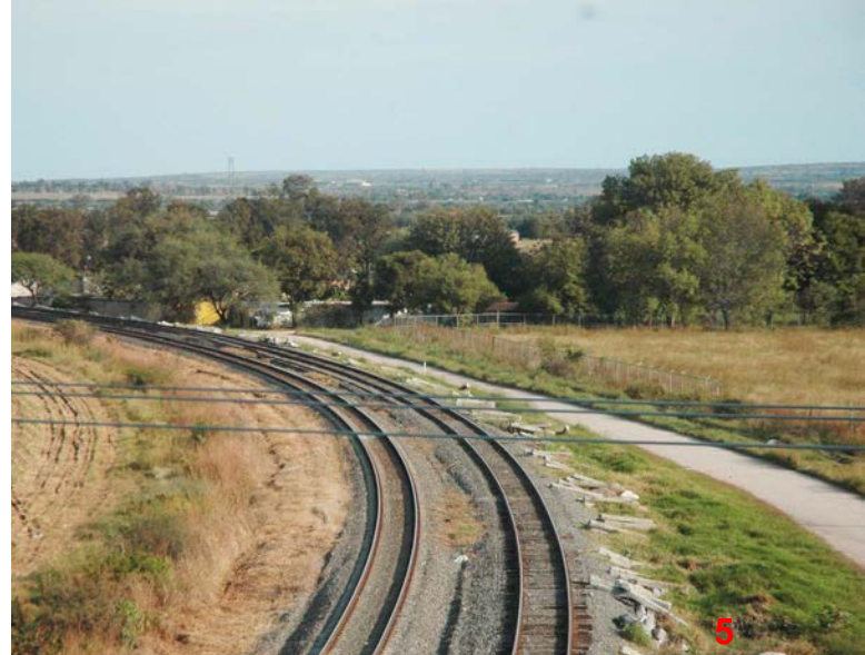
La ligne de chemin de fer séparant l'espace agricole et un espace foncier non bâti.
