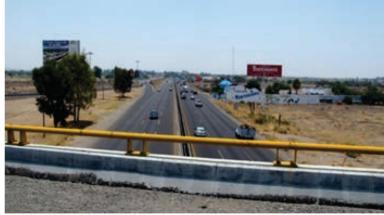
L'autoroute 45 est très difficilement franchissable et constitue une limite forte dans le territoire métropolitain.
