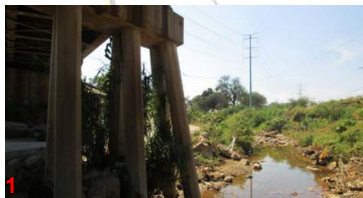
Point de rencontre de la rivière, de la voie ferrée et de la voirie.
