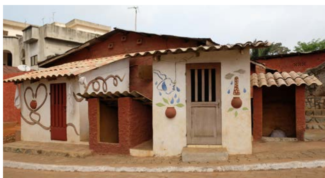
Visite des places réhabilitées
