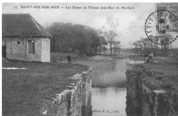
a comporta de Mardyck e do canal de Mardyck antes da sua restauração
