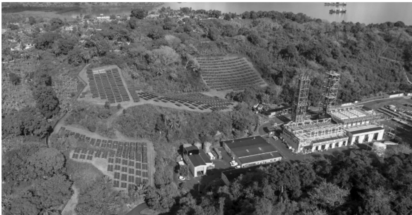
Panneaux solaires à la centrale électrique de Longoni
