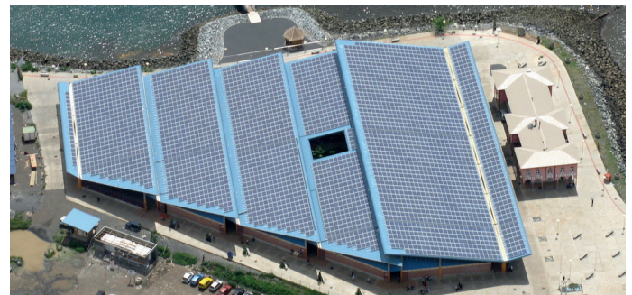
Ci-dessus: Port de Longoni (Les Ateliers) Le toit du marché de Mamoudzou est aussi la plus puissante installation solaire de l'île à ce jour (Albioma)
