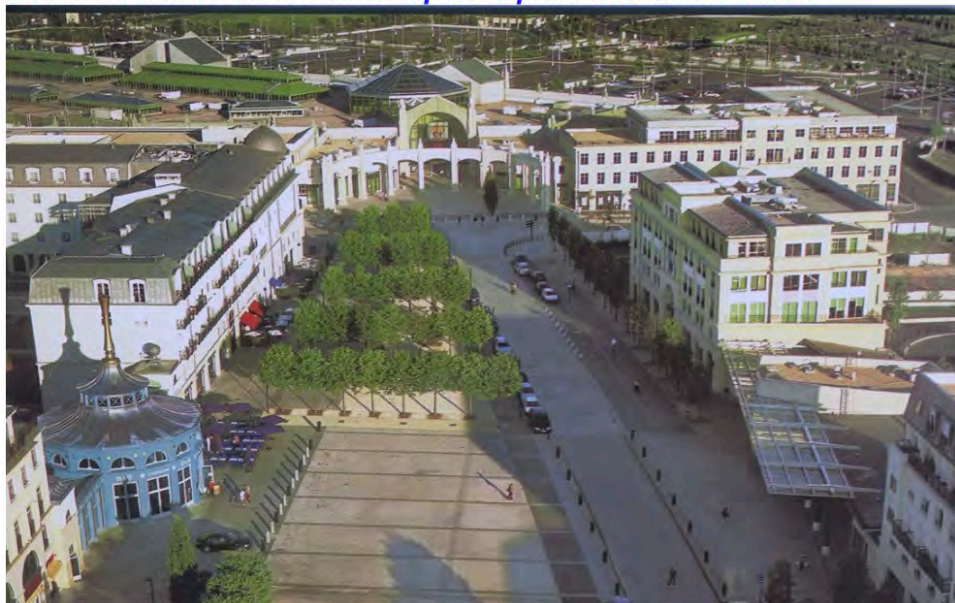
Entrée du Centre-Commercial depuis la place d'Ariane à Serris.
