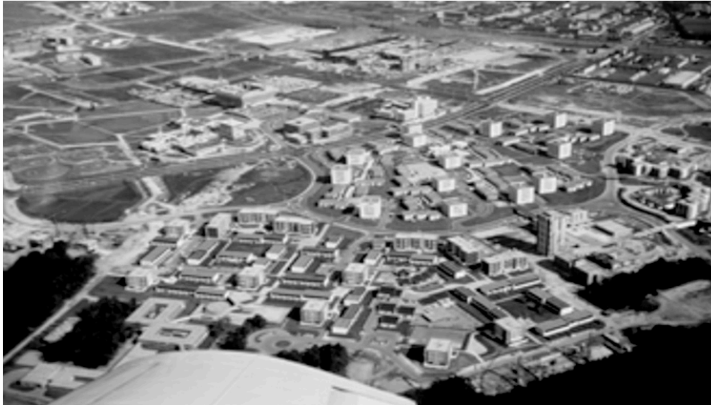
Les Toulousees. Un quartier piétonnier de la préfecture en 1972. (Texte ci-dessous)
