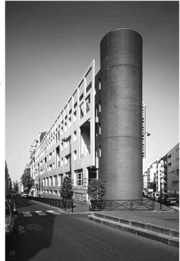
1988 - Ecole Maternelle et 50 logements Rue du Ruisseau PARIS 18e
