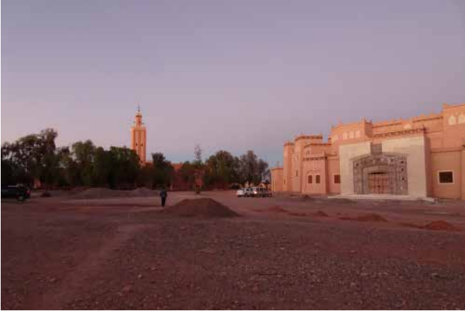
Quartier El Wahda: la mosquée et le centre culturel en chantier, livraison été 2018.
