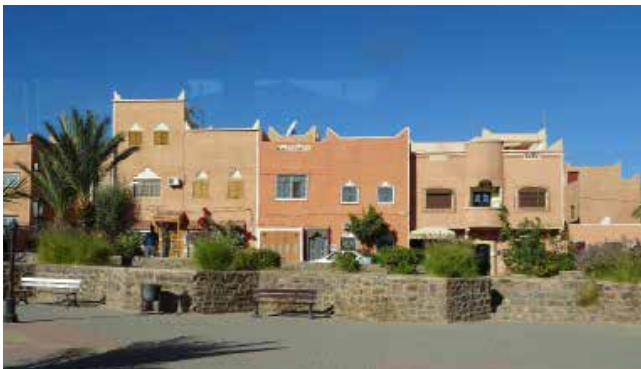
Unité architecturale, et éléments de modénature caractéristiques
