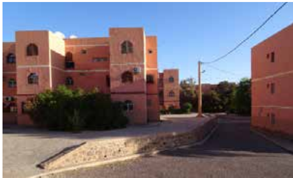
Logements collectifs sociaux
