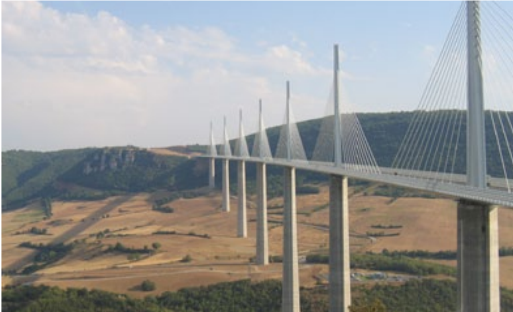
Viaduc de Millau. Cliché : C.M., 2006.
