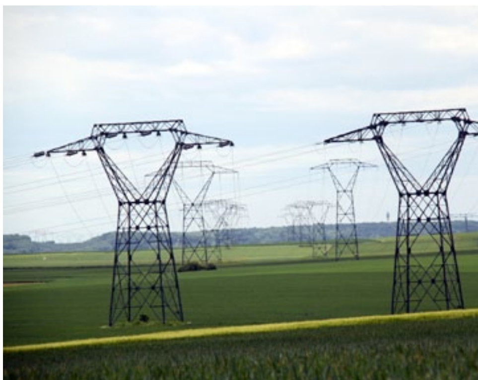
Pylônes à Cergy- Pontoise. Exercice photographique sur le thème de l'atelier avec Peter Knapp, photographe et des étudiants de l'Ecole supérieure de design, d'art graphique et d'architecture Penninghen. Cliché d'un étudiant.
