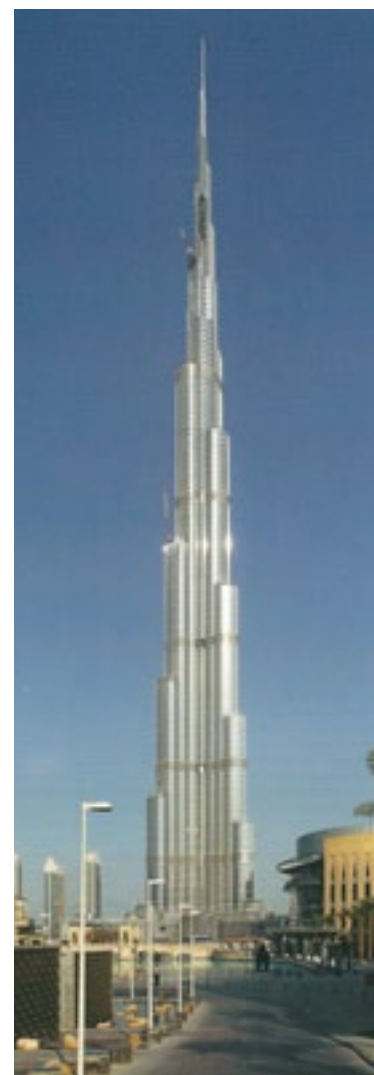
Tour Burj Khalifa, Dubaï, architecte : SOM (Skidmore, Owings & Merrill). Pièce maîtresse d'un quartier nouveau, le Downtown Dubaï. Situé sur une péninsule artificielle, le caractère monumental est accentué. Source : FIRLEY E., GIMBAL J., La ville et la tour , 2011.
