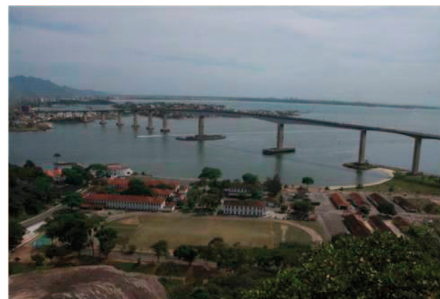
Terceira Ponte entre Vila Velha e Vitória/ Troisième Pont
