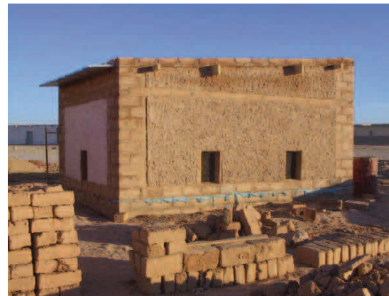
Exemple de maison avec structure et remplissage en BTC
