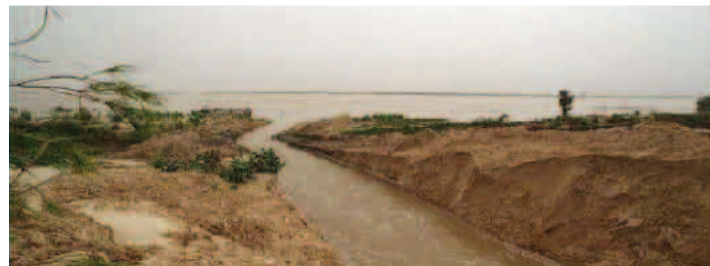
Ouverture du canal de délestage en 2003, d'une largeur de 4 m
