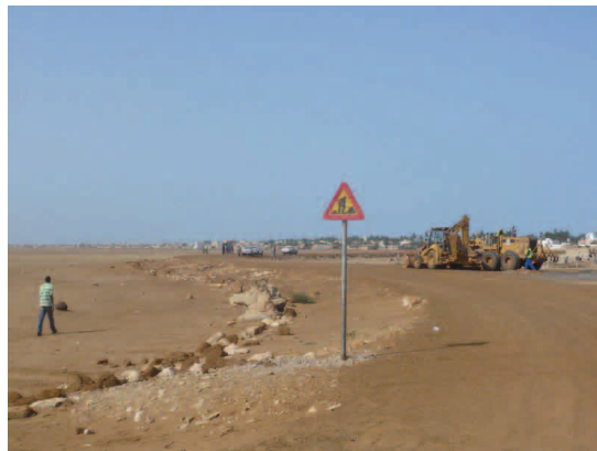
La digue de Sor préserve le quartier des crues du fleuve, mais empêche l'écoulement des eaux pluviales
