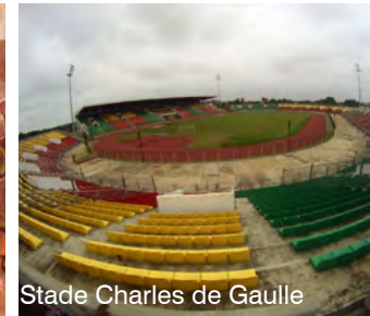
Des équipements existants à valoriser
