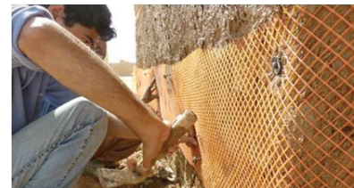
Des exemples de réhabilitation anti-sismiques
