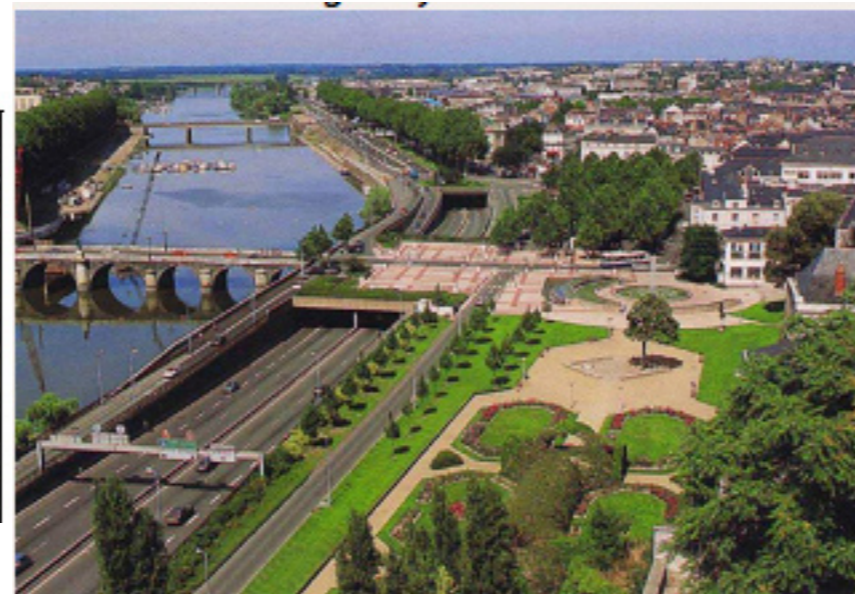
Vue de la RN23 le long de la rivière Maine
