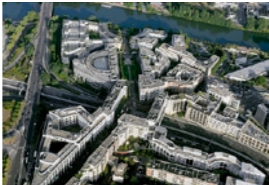
Rueil-Sur-Seine, tertiary district In Rueil-Malmaison Source : CG92 Flickr
