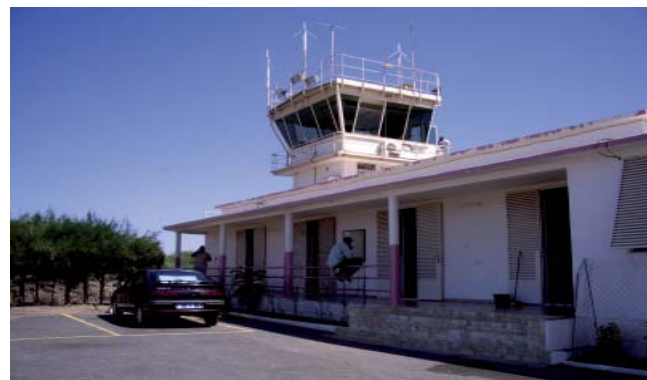
Tour de contrôle et bloc technique
