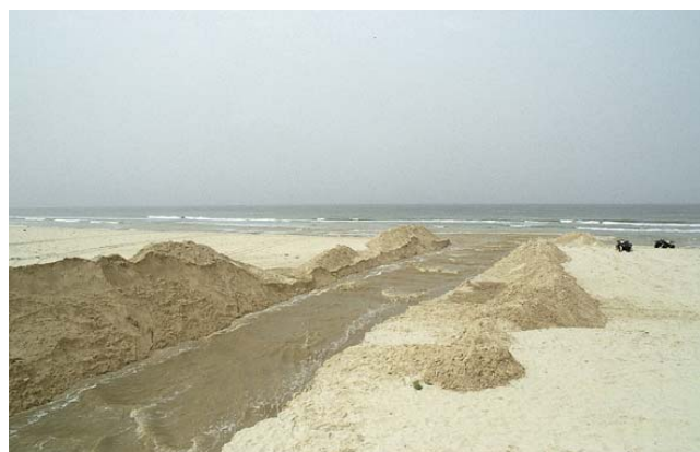
Ouverture du canal de délestage,
