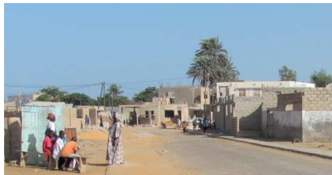
Restructuration urbaine de Pikine : nouvelle rue.
